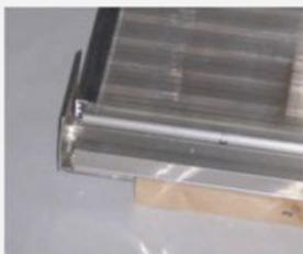
Dann wird die erste Platte aufgelegt, bis an die Haltewinkel geschoben und ausgerichtet
