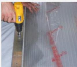
Achten Sie darauf, dass die gekennzeichnete Plattenoberfläche nach oben zeigt. Dann wird die Platte auf der Längsseite mit Hilfe des Oberteils des Profilsystems befestigt.
