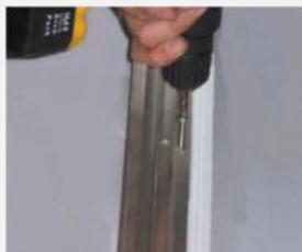
Danach werden die Unterteile des jeweiligen Profilsystems auf der Unterkonstruktion befestigt.
