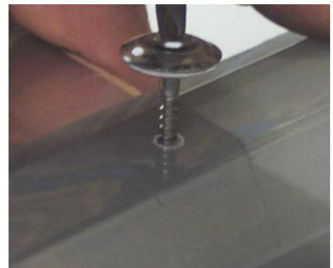
Mit der gekennzeichneten Fläche nach außen auf die Unterkonstruktion legen. Bei strukturierten Wellplatten ist die strukturierte Seite nach innen zu verlegen. PVC- und Polycarbonat-Wellplatten sind mit der gekennzeichneten UV-Schutzseite nach außen zu verlegen.
