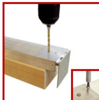
Legen Sie den Abschluss- und Haltewinkel an der Unterseite des Unterprofils so an der Kante an, dass der Wasserablauf frei bleibt (siehe Bild). Bohren Sie nun das Unterprofil 2 mal ( $\varnothing$  3,5 mm) vor. Befestigen Sie anschließend den Winkel mit 2 Edelstahlschrauben (4,2 x 16mm) am Unterprofil.
