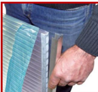
Montieren Sie dann an der Unterseite (Traufe) die Alu-U-Abschlussprofile mit Tropfnase nach unten. Die Schutzfolie wird dabei nur soweit entfernt wie es zur Befestigung nötig ist.
