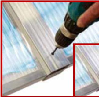
Nacheinander immer zwei Platten auflegen, ausrichten und fixieren. Kunststoffsteg durch die Bohrungen im Oberprofil vorbohren (Ø 5mm) Dann Profil und Steg mit Edelstahlschrauben (Metall) 6,3 x 38mm verschrauben.
