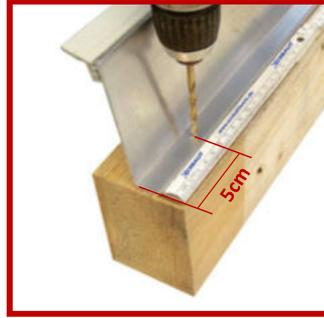
Bohren Sie den Alu-Wandanschluss. Der Bohrdurchmesser richtet sich nach den verwendeten Schrauben. Die erste Bohrung erfolgt nach ca. 5 cm, die folgenden Bohrungen immer in einem Abstand von ca. 40 cm.
