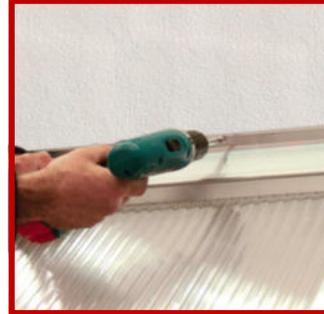
Verschrauben Sie das Profil mit geeigneten Schrauben.
