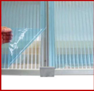
Legen Sie die Platte auf und richten Sie diese winkeligerecht aus. Plattenabstand 30 mm. Die gekennzeichnete Schutzfolie nach oben - UV-Schutz!
