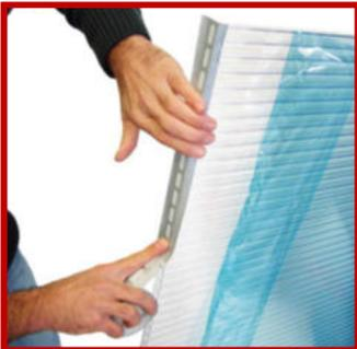
Bringen Sie das passende Kantenverschlussband am Ende der Platte an. Es verhindert das Eindringen von Staub, Schmutz und Insekten. Die Membranversion lässt gleichzeitig die Lüftung der Hohlkammern zu.
