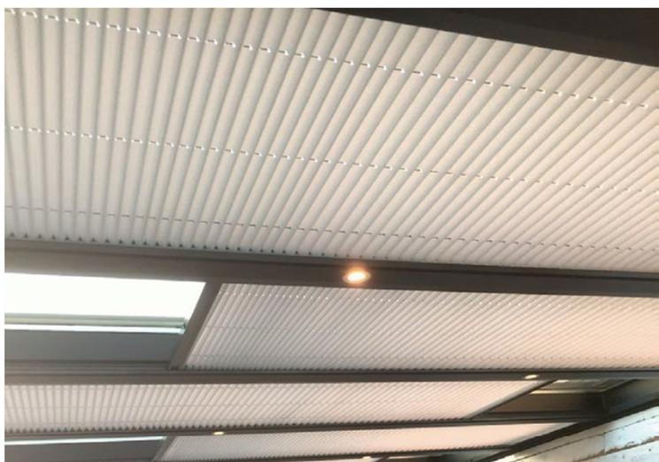
Die Beschattungselemente lassen sich auf Wunsch an jeder beliebigen Stelle mittels einer Zugstange aufschieben. Sie werden zwischen den Sparren unter den transparenten Dachplatten, z.B. Glas oder PC-Hohlkammerplatten, montiert. Je nach Dauergebrauchstemperatur des Bedachungsmaterials ist auf eine ausreichende Be- und Entlüftung des Zwischenraumes zu achten.
