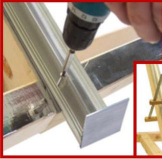
Vorbereitete Profilunterteile auflegen. Abschluss- und Haltewinkel können komplett überstehen (Wenn nicht möglich in den Sparren ausklinken). Profile exakt ausrichten, mit Zwingen fixieren und verschrauben.
