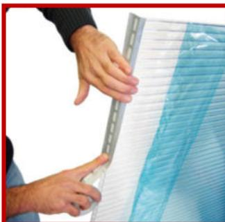
Bringen Sie das passende Kanten-Verschlussband an den Enden der Platte an. Es verhindert das Eindringen von Staub, Schmutz und Insekten. Die Membranversion lässt gleichzeitig die Lüftung der Hohlkammern zu.
