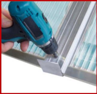
Nacheinander immer zwei Platten auflegen, ausrichten und fixieren. Profiliberteile Rand und Mitte auflegen und Edelstahlschrauben (Metall6,3x 32 mm) oder Bohrschrauben (5,5 x34 mm) mit dem Unterteilen verschrauben. Fortfahren Bis zur letzten Platte. Diese dann einmessen, ggf. zuschneiden und mit Randprofil montieren.
