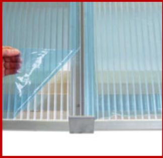
Legen Sie die Platte auf und richten Sie winkeltgerecht aus. Plattenabstand 30 mm. Die gekennzeichnete Schutzfolie nach oben - UV-Schutz!
