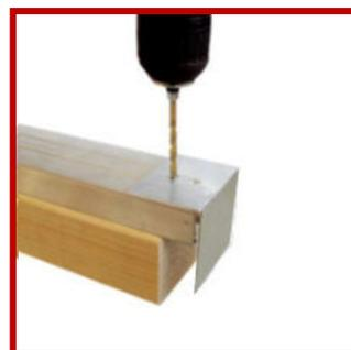
**Tipp:** Oder verwenden Sie zur Befestigung des Abschluss- und Haltewinkels unsere Bohrschrauben (5,5 x 34 mm). So entfällt das vorbohren. Eine Schraube pro Winkel ist ausreichend.
