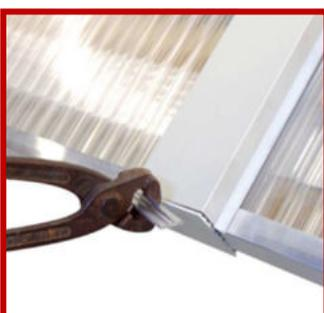
Nun kann der Abschluss- und Haltewinkel je nach Höhe des Profils (mit oder ohne Zierklemmdeckel) mit einer Zange abgebrochen werden.
