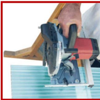
Schneiden Sie die Platten auf Endlänge. Berücksichtigen Sie hierbei einen ausreichenden Traufüberstand. Sägespäne in den Hohlkammern mit Druckluft oder Staubsauger entfernen.
