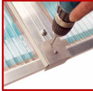
Legen Sie danach den Abschluss- und Haltewinkel vorne bündig auf das Oberprofil auf und bohren dieses vor. Bohrdurchmesser 3mm! Befestigen Sie anschließend den Winkel mit Scobalit Edelstahlschrauben (Metall) 4,2 x 16 mm. Nun kann der Abschluss- und Haltewinkel je nach Höhe des Profils mit einer Zange abgerochen werden.
