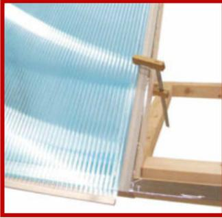
Legen Sie die erste Platte auf die Unterkonstruktion auf, richten sie winkeligerecht aus und fixieren sie mit Zwingen. Die Seite mit der gekennzeichneten Schutzfolie muss nach oben gerichtet sein!
