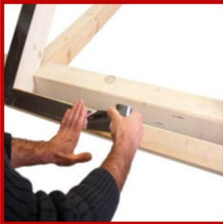
Bringen Sie zuerst das reflektierende Klebeband Silber auf den Sparrenoberseiten und Querriegel an, oder streichen Sie diese weiß. (Für alle Holz-Oberseiten die nicht vom Verlegeprofil verdeckt werden).
