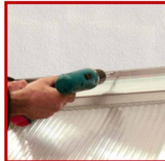
Verschrauben Sie das Profil mit geeigneten Schrauben.
