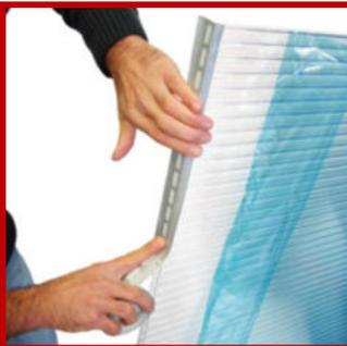
Bringen Sie das passende Kantenverschlussband an den Enden der Stegplatten an. Es verhindert das Eindringen von Staub, Schmutz und Insekten. Die Membranversion lässt gleichzeitig die Lüftung der Hohlkammern zu.
