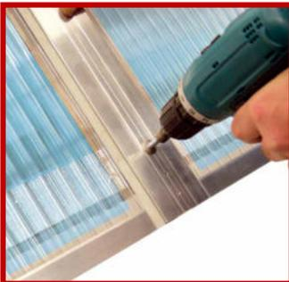
Verschrauben Sie dann das erste Mittelprofil. Verwenden Sie nur Edelstahlschrauben 6,5 x 64 mm bei Holzkonstruktion. Achten Sie darauf, dass das Profil bündig mit den Platten abschließt!
