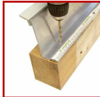
Bohren Sie den Alu-Wandanschluss. Der Bohrdurchmesser richtet sich nach den verwendeten Schrauben. Die erste Bohrung erfolgt nach ca. 5-6 cm, die folgenden Bohrungen immer in einem Abstand von ca. 40 cm.
