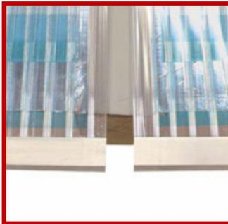
Legen Sie die folgende Platte auf und richten Sie winkeligerecht aus. Plattenabstand 30 mm. Die gekennzeichnete Schutzfolie nach oben - UV-Schutz!
