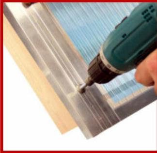
Verschrauben Sie jetzt das erste Randprofil. Verwenden Sie nur Original Scobalit Edelstahlschrauben 6,5 x 64 mm bei Holzkonstruktion. Achten Sie darauf, dass das Profil bündig mit den Platten abschließt!
